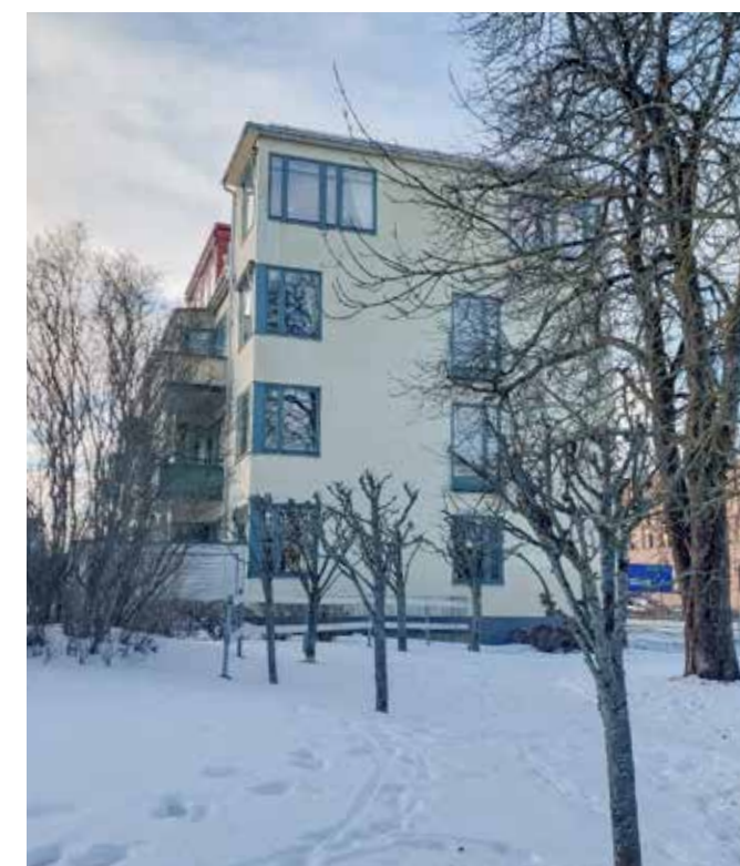
Detaljering puts. Kvarteret Varmbadet 18. Arkitekt: Södergruppen arkitekter (2003)
